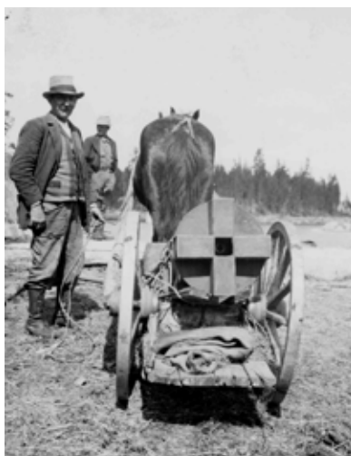
▲ En vagn med vält, framtagen särskilt för arbete med att bygga cykelstigar. Välten kunde fästas vid hjulen på vagnen och användes för att hårdgöra ytan på cykelstigen.
