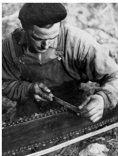
▲ Filning av sågkedjan på fri hand.
